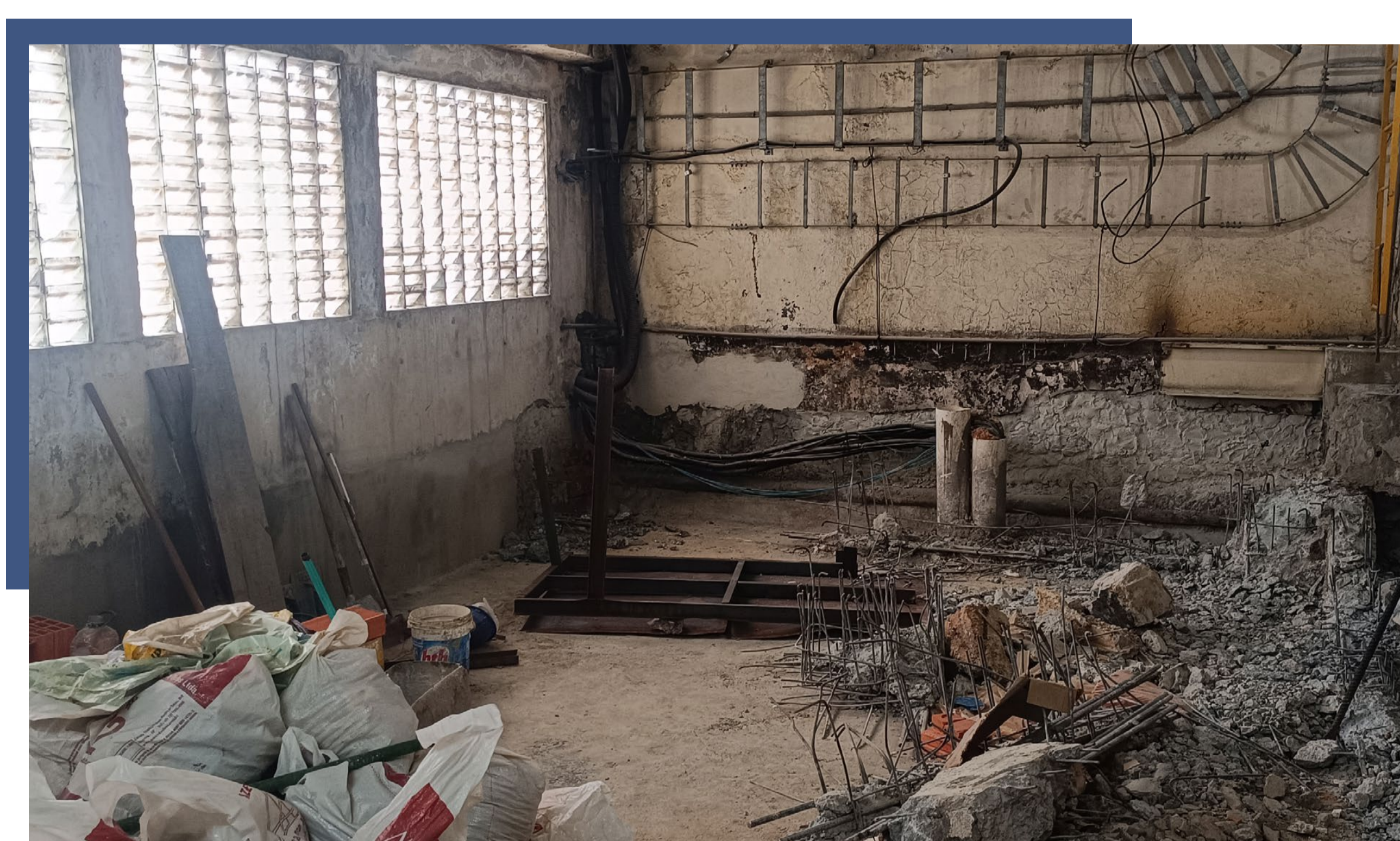
Fase inicial da obra
