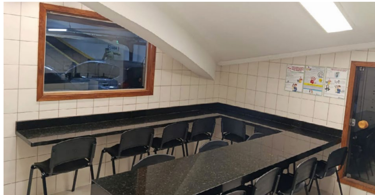
Reforma da copa para uso dos colaboradores do Condomínio e das empresas aqui sediadas
