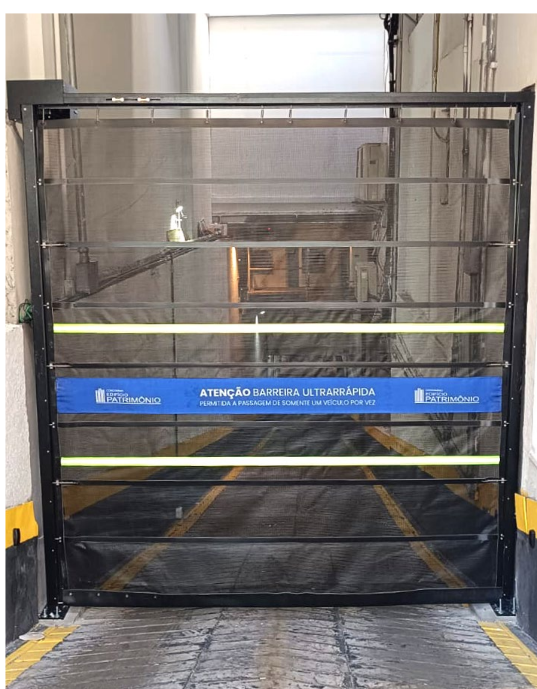
Instalação de portão ultrarrápido (Smart Gate) na saída do estacionamento
