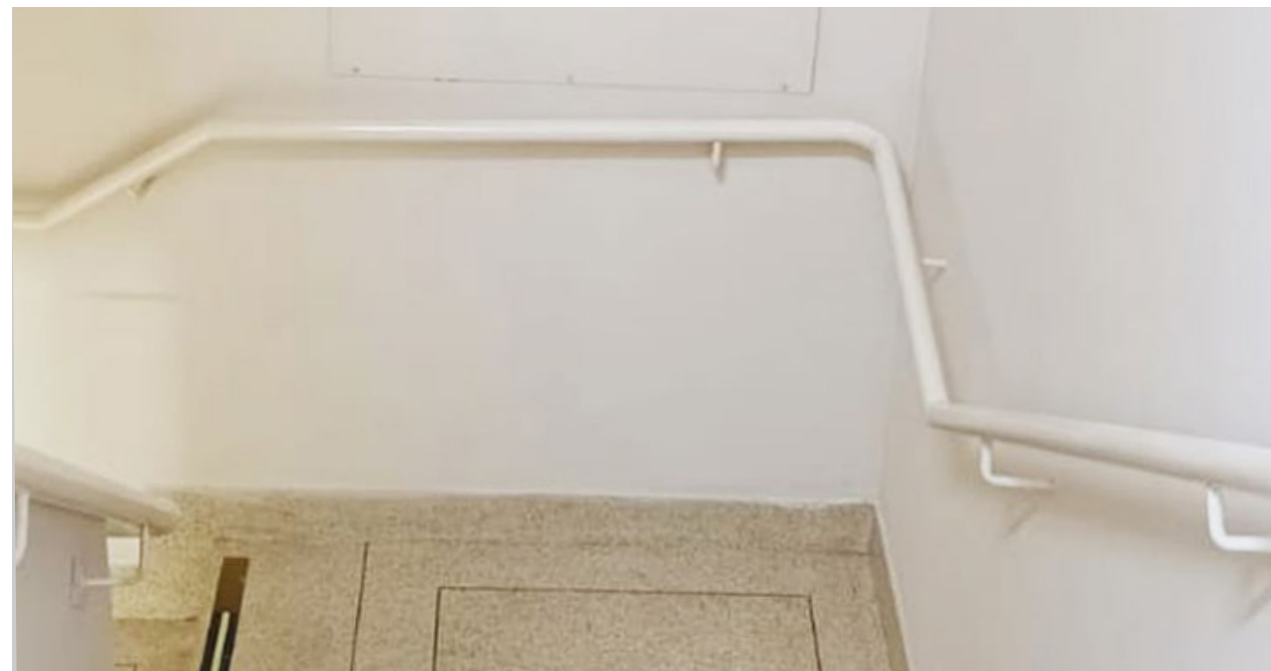
Pintura das escadarias de emergência
